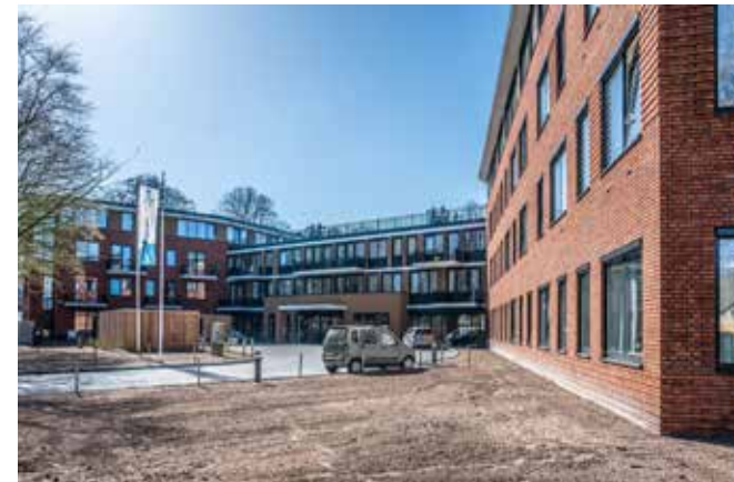
Het complex omvat twee villa's die verbonden worden door een middengebiet met daarin een ontvangst, meerdere kantoren en 'specialistenruimtes'.
