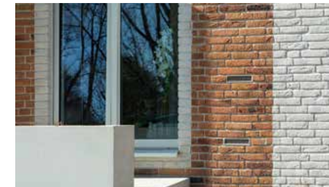
De roosters in de gevels zijn bijna niet zichtbaar en doen niets af aan het schitterende gebouw.
